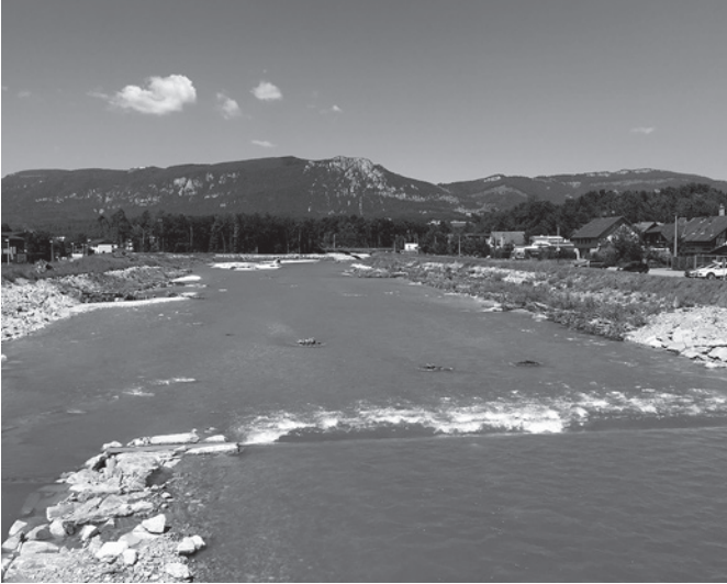
... und nach der Sanierung und Aufweitung
